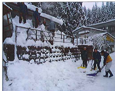
連携作業で順調に進んだ除雪作業
