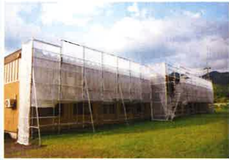
大規模修繕の様子
